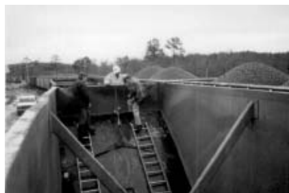
Установка TIVAR® 88-2 на торцевые стенки.
