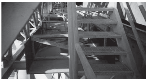
Фото С Предварительно изготовленный футеровочный материал TIVAR® 88-2 для лоткового транспортера готов к установке. Часть 6' в ширину, 24' в длину с боковыми стенками в 2' высотой.
