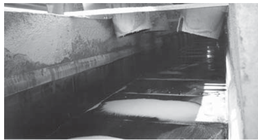
Фото D После того, как была размещена каждая 24' часть, их сварили бесшовным способом в единый 96' бесшовный блок. Использование минимального числа элементов крепления (всего 24 в первом отделе) и направляющей защитной кантовой рейки завершило установку.
