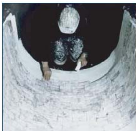
Футеровка лотка шлака
